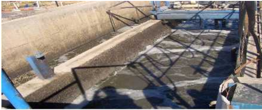
Photo 12 - Bassin dessablage-déshuilage_(Amar S., 2015).
