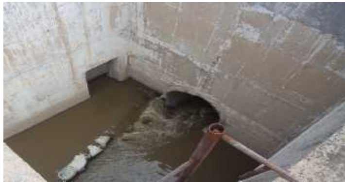
Photo 8 - Déversoir d'orage de la STEP (Amar S., 2015).
