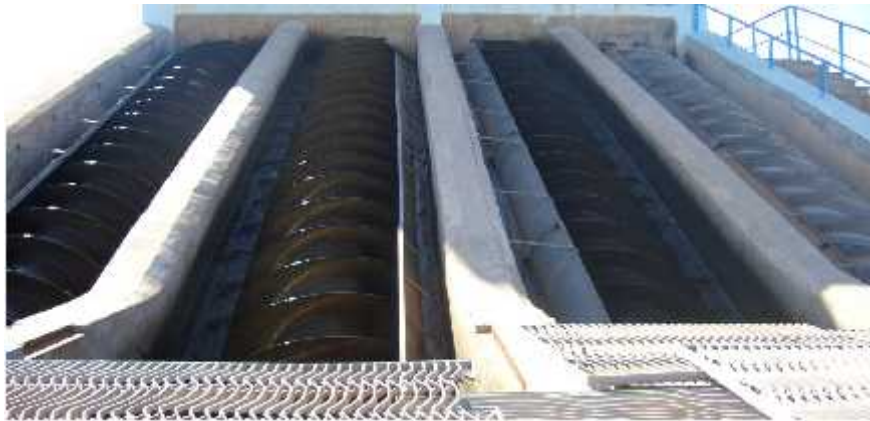
Figure 32 - Les vis d'Archimède (Amar S., 2015).
