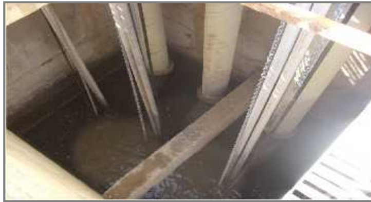
Photo 6- Relevage par des pompes (Archive ; ONA, 2015)
