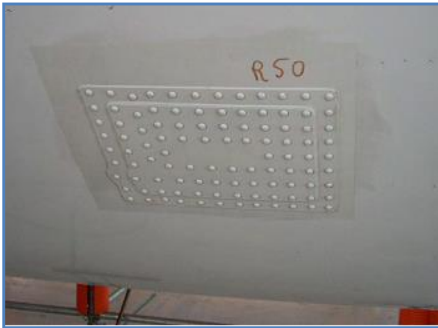
Figure III.7: Réparation par patch riveté sur fuselage de Boeing
