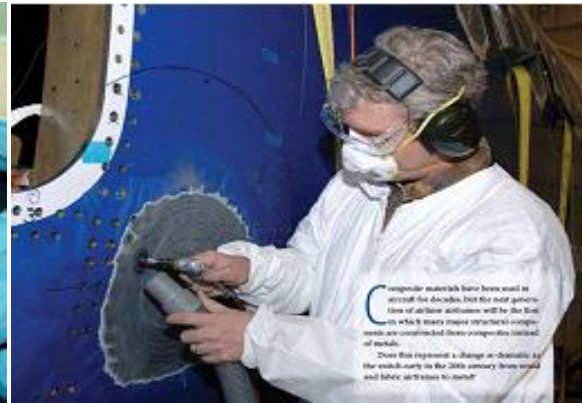
Figure III.9: Opération de ponçage de la zone endommagée directement sur fuselage [40]
