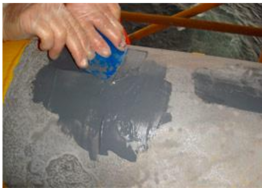
Figure III.2 réparation d'un pipe par collage de patch
