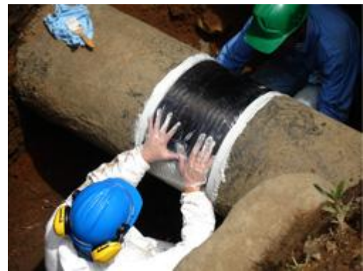
Figure III.2 réparation d'un pipe par collage de patch
