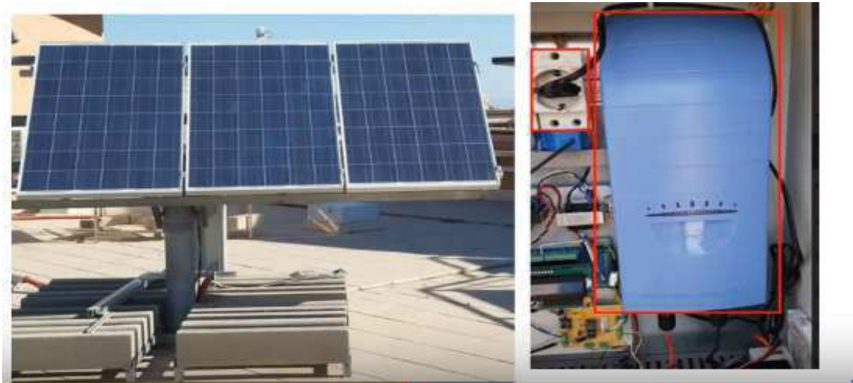
Figure 5. 34 La centrale situer en Espagne (565 W): 3 panneaux de 185 W, Onduleur 600w raccordé au réseau.
