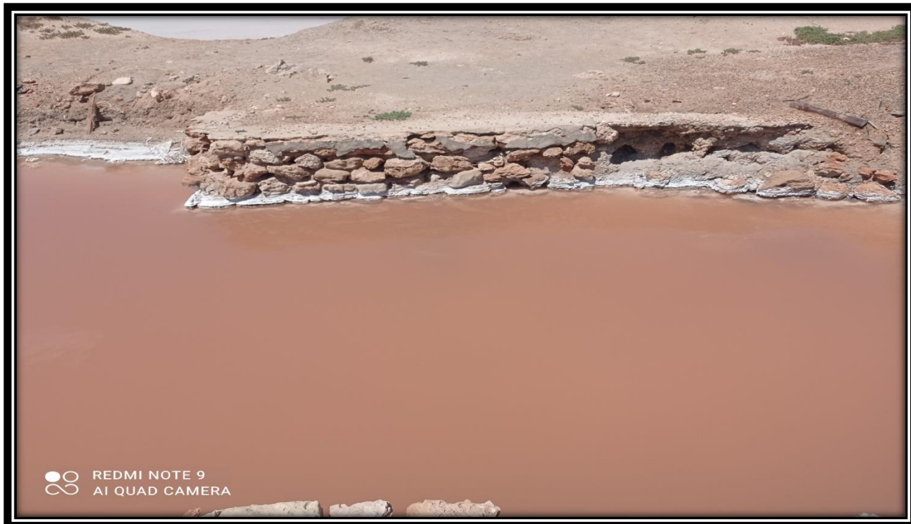
Fig 35 : Canal déverseur du circuit de lavage ENASEL des Saline D'Arzew(©Doukani, 2021)
