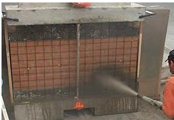
Fig.1.2 : Béton projeté sur un mur en maçonnerie.
