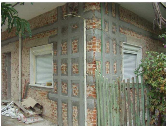
Fig.1.8 : Exemple de renforcement des bâtiments en maçonnerie par PRF [SIK.2003].
