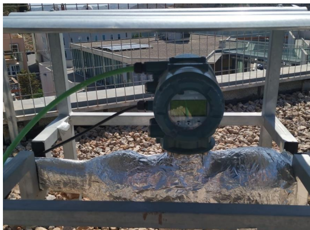
Figure 4.24 Débitmètre monté horizontalement.
