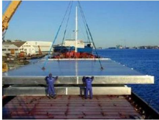
Figure 1.18: Panneaux préfabriqués (Hydro Marine Aluminium) destiné au pont du bateau de croisière "The World" [Zimmer. 16].
