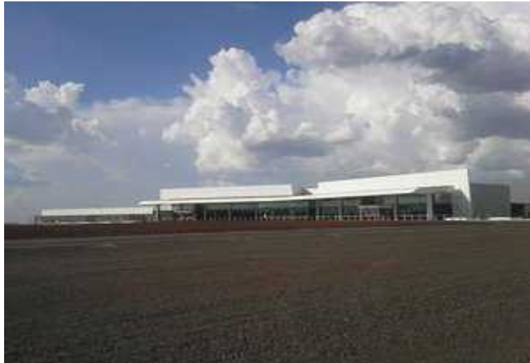
Figure I.8 : le nouvel aéroport « Brisbane West Wellcamp » en Australie réalisé avec un béton géopolymère. [10]
