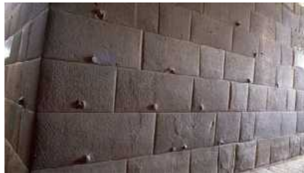
Figure I.6 : précision millimétrique dans la forme des blocs de pierres. [9]
