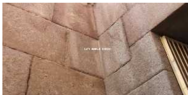
Figure I.7 : formes complexes et précision millimétrique dans la forme des blocs de pierres «bloc de pierre sous forme L». [9]
