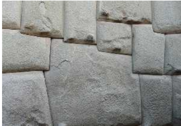
Figure I.5: formes complexes des blocs de pierres. [9]
