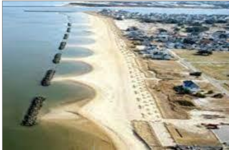
Fig. II-2 – Protection des plages contre l'érosion par les brise-lames.
