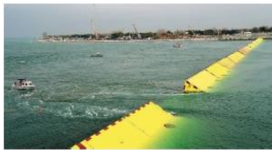
Projet MOSE des brise-lames flottants pour protéger Venise
