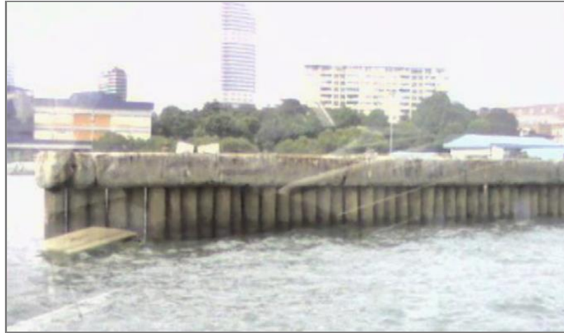
Fig. II-7 - Brise-lames type mur à fentes perçant la surface (Singapour).
