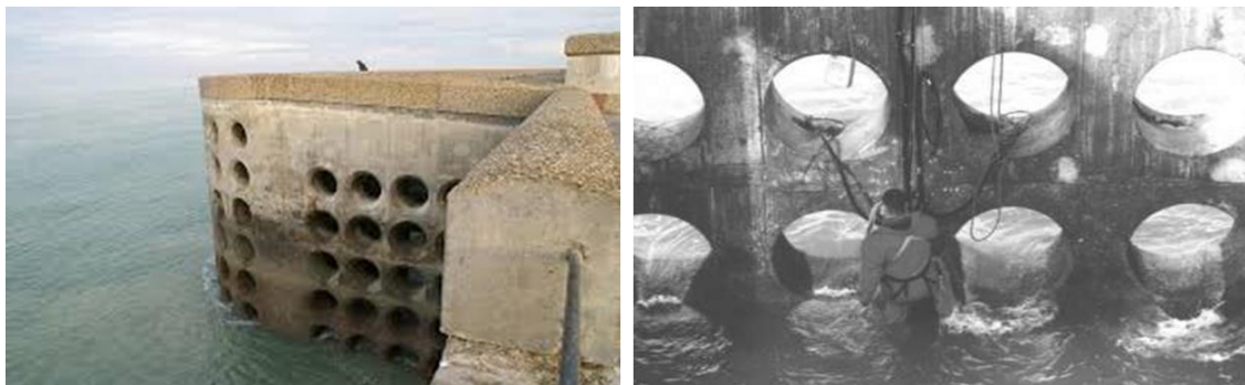
Fig. II-9 – brise-lames type système de chambre perforée, Dieppe (France).
