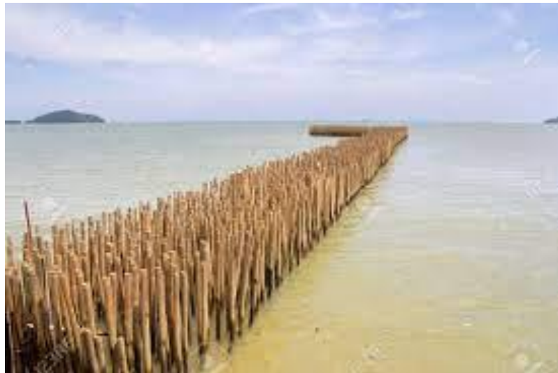
Fig. II-14 - Brise-lames constitué d'un mur de clôture en bambou, Phuket (Thaïlande).
