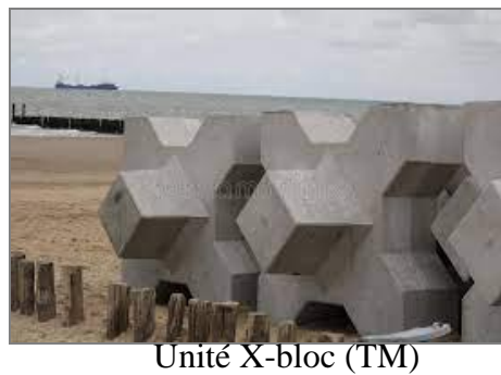
Fig. II-6 - Types de blocs de blindage en béton (nouvelle génération).
