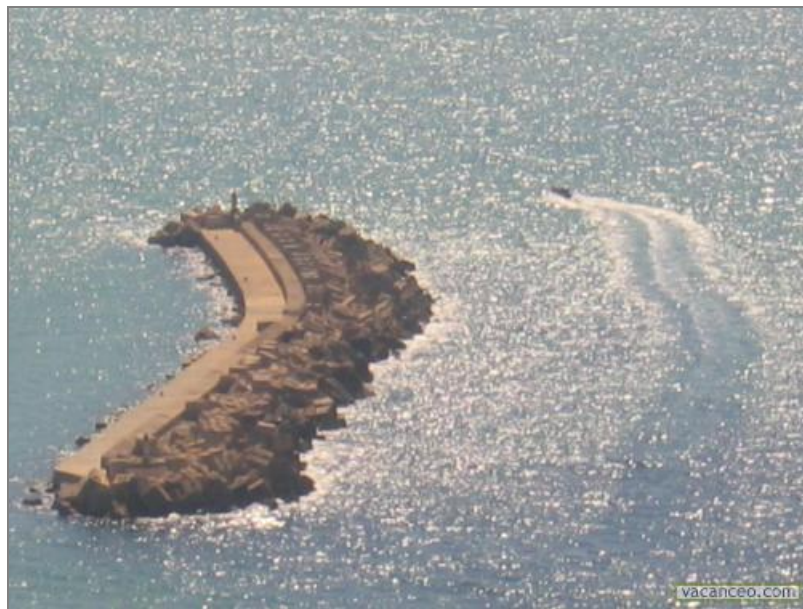
Fig. II-1 – Brise-lames de tumulus de longueur 405 mètres, construit de 1880 à 1890 (Ing. Alcaÿ et Helfferich) au port de Ténès, Algérie.
