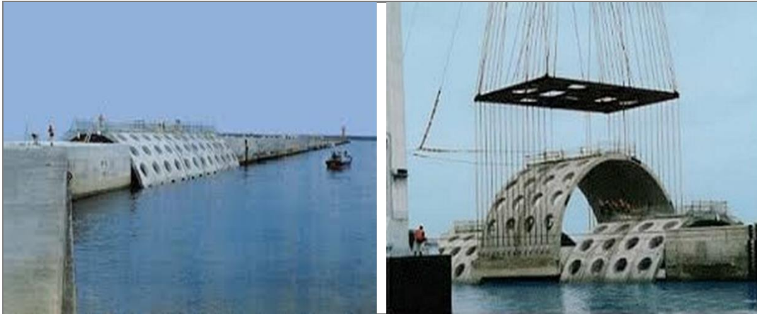
Fig. II-10 – Brise-lames semi-circulaire (SBW) perforé, port de Miyazaki (Japon).
