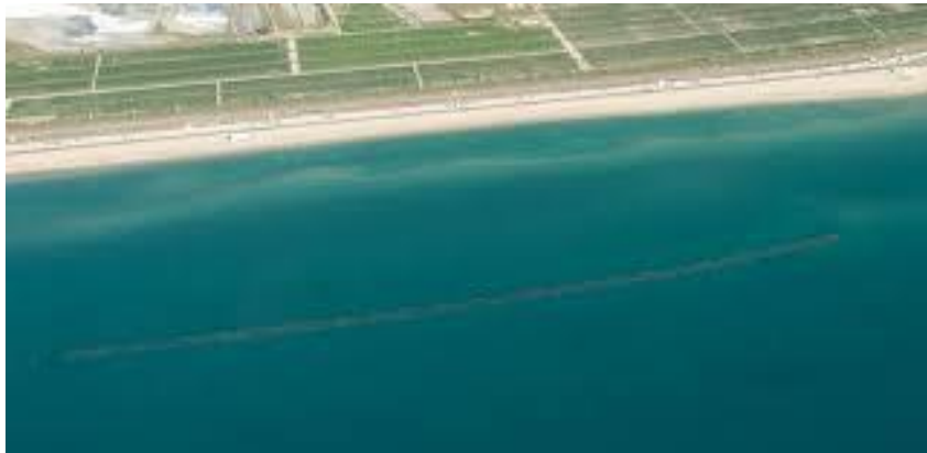
Fig. II-16 - Vue aérienne du brise-lames immergé installé avec des éléments remplis de sable encapsulés à la plage du Lido, Sète, France.
