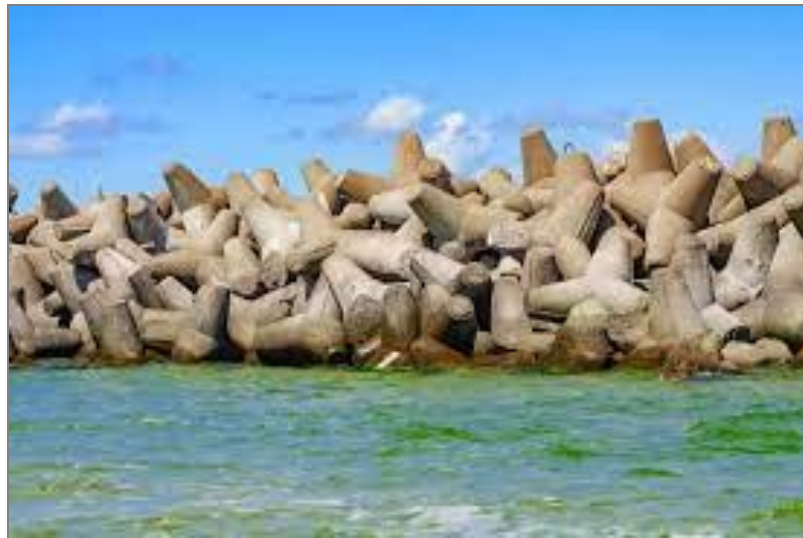
Fig. II-4 - Brise-lames formé de blocs de béton tétrapodes.
