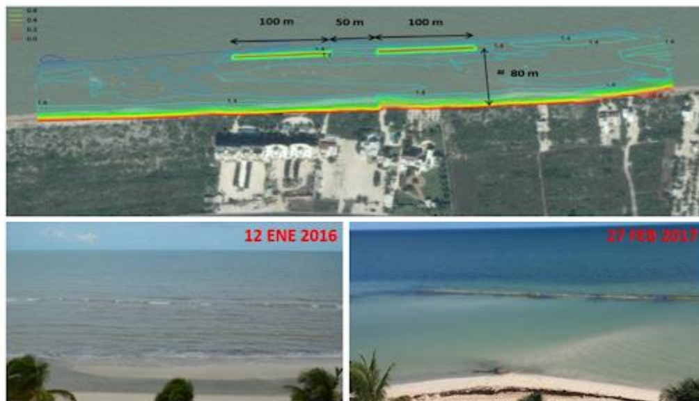
Fig. II-18 - Stabilisation avec brise-lames submergés de la plage San Bruno, côte nord du Yucatan, Mexique.
