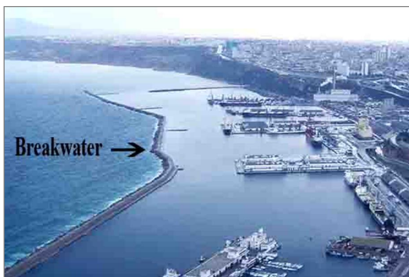
Fig. I-1 – Principales fonctions d'un brise-lames sont l'accostage et la protection contre les vagues.
