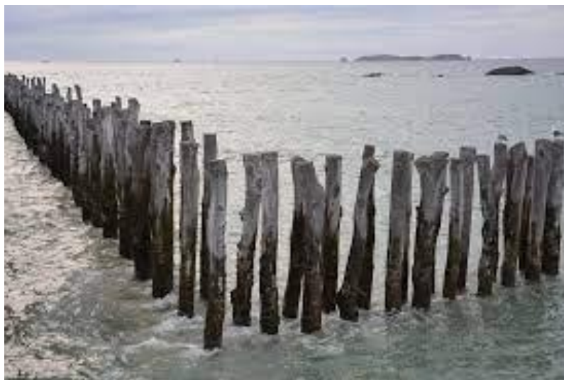
Fig. II-13 - Troncs d'arbres servant de brise-lames, Saint-Malo (France).
