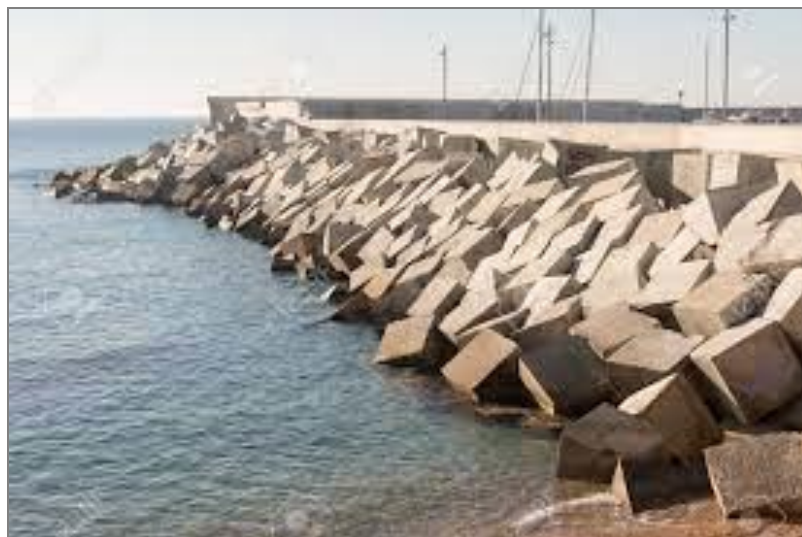
Fig. II-3 - Brise-lames formé par des blocs de béton.
