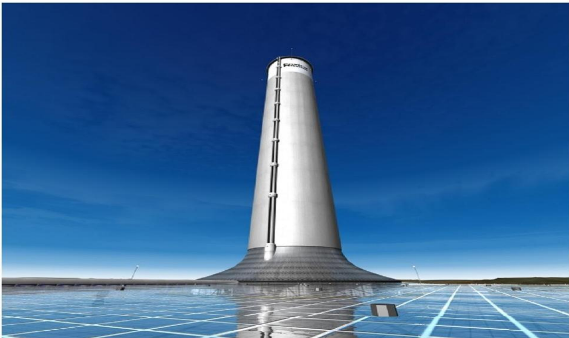
Fig. I.5 la centrale d'Enviro- Mission en Arizona
