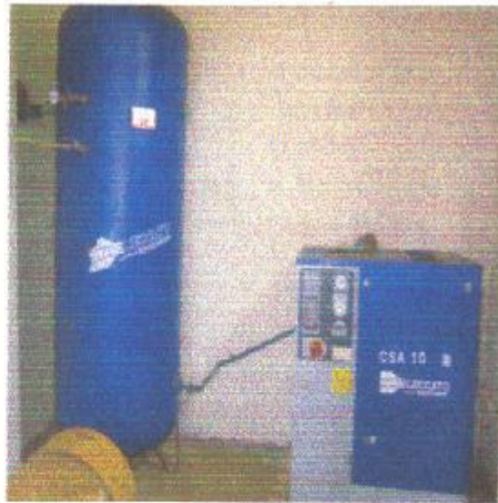
compresseur dégage l'air pour nettoyer la crépine
