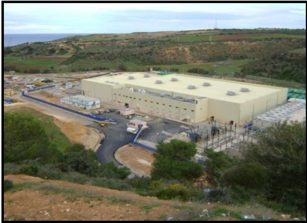
Figure 46 - Station de dessalement de Chat el Hillal.
