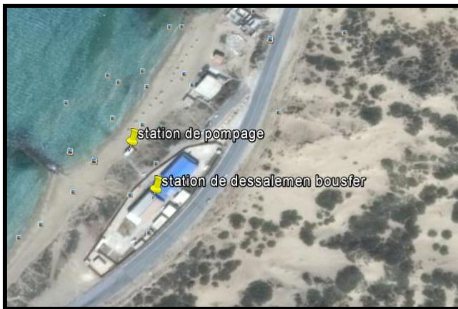
Figure 41 - Station de dessalement de Bousfer [ Image Landsat 2015 Google ] .
