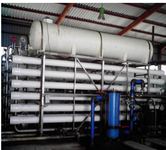
Figure 9- Schéma du procédé simplifié d'osmoseur (Anonyme 01 , 2003).
