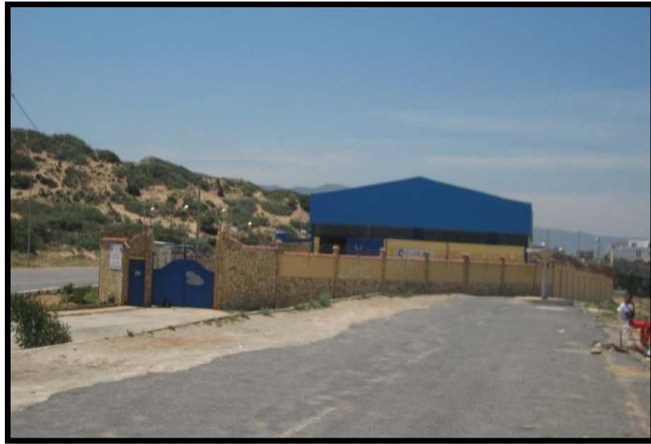
Figure 40 - Station de dessalement de Bousfer.
