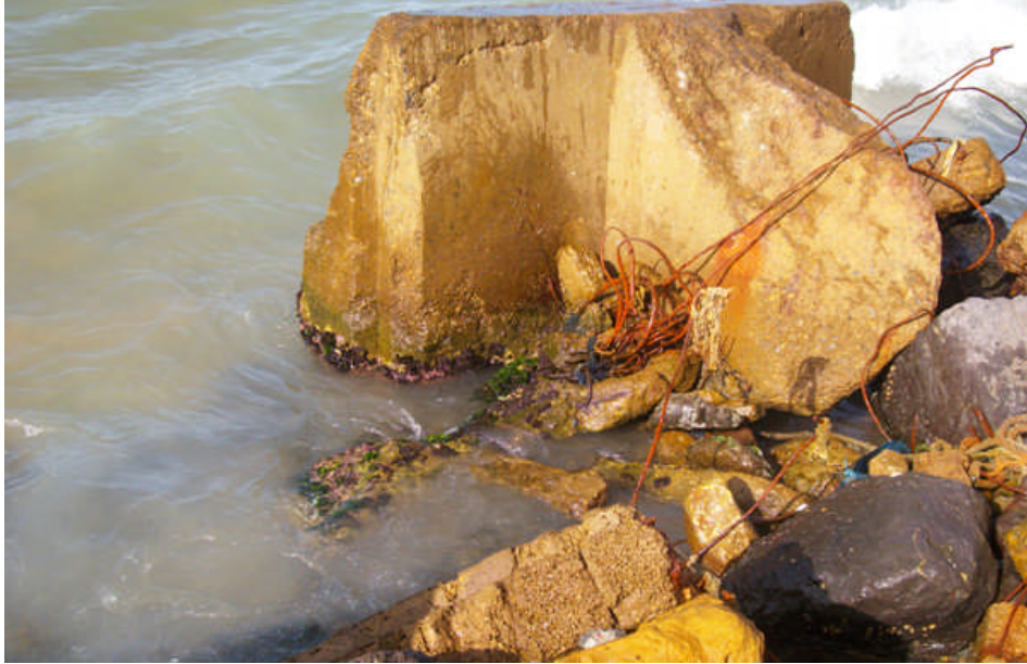
Figure IV.8: Photo du site Ferphos (port de Beni saf) (Site de prélèvement des algues)
