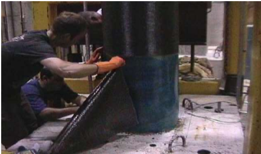
Figure I.13: Renforcement avec plaques en FRP
