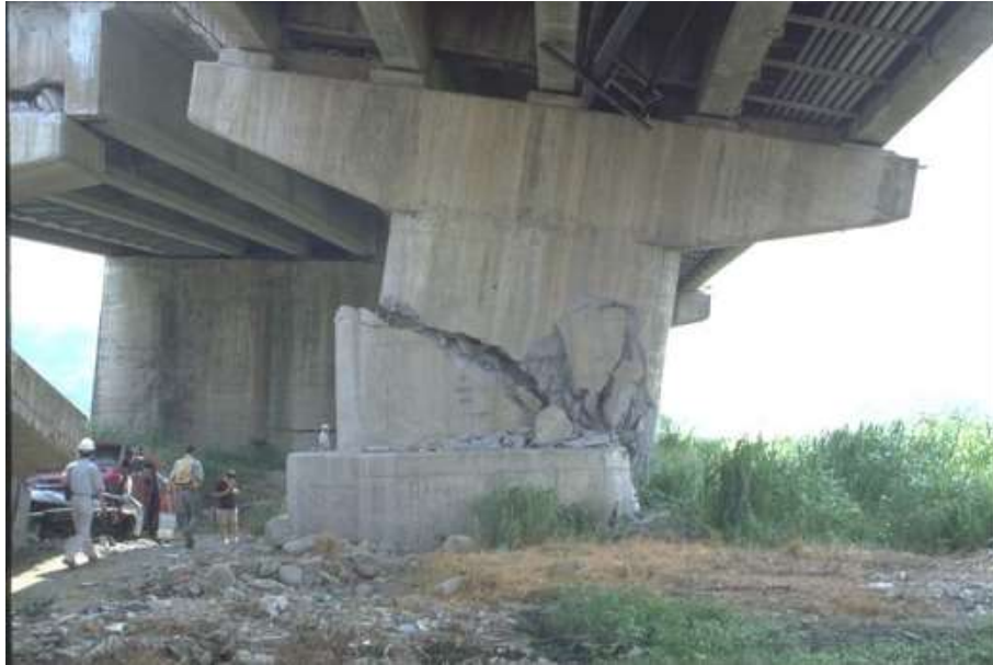
Figure I.3: Ruptures par cisaillement des piles (D. DAVI et al, 2013)
