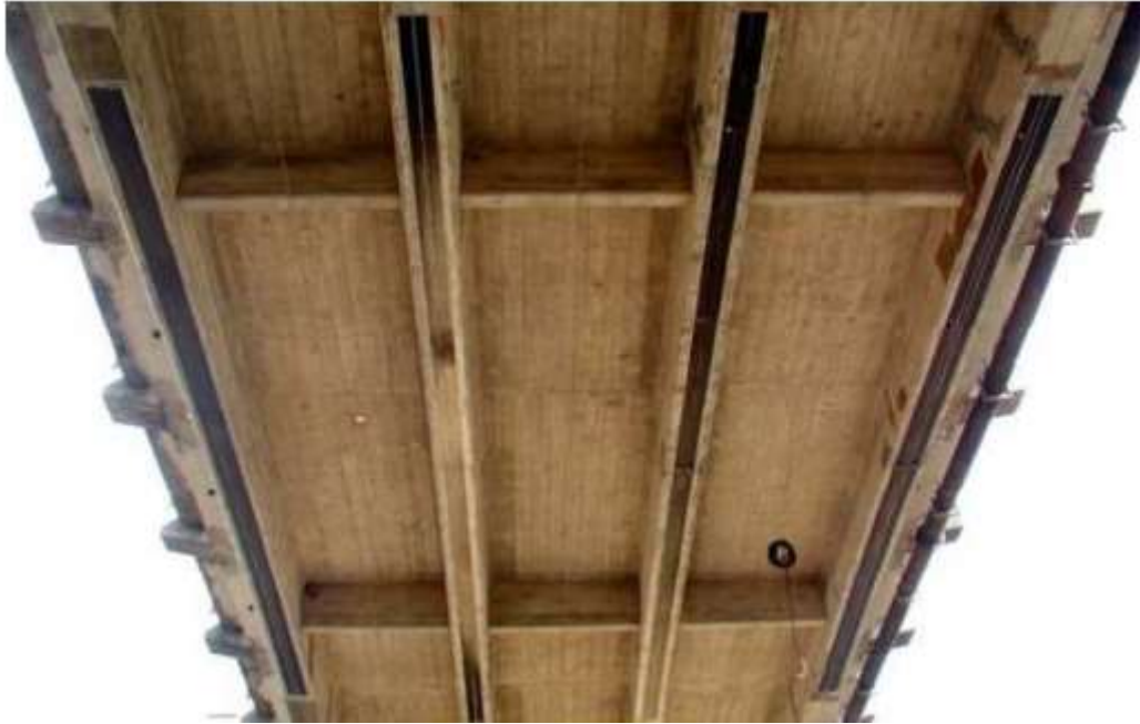
Figure II.15: Poutres de pont en béton armé renforcées par collage de plaques
