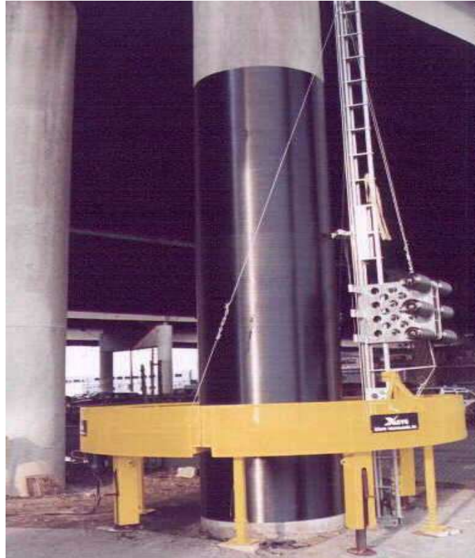
Figure II.16: Procédé de l'enroulement filamentaire (Balaguru et al., 2009)
