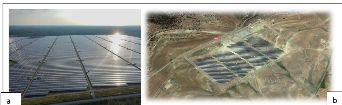
Figure 1.35.a) Centrale solaire photovoltaïque (Cesta) [58] b) Image satellitaire centrale Dhaya Sidi Bel Abbés (47 808 panneaux)
