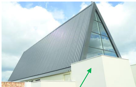
Couverture de toiture en sandwich.
