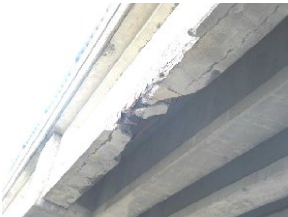
Figure I-13 choc à cause des poids lourds hors gabarit contre l'intrados du pont
