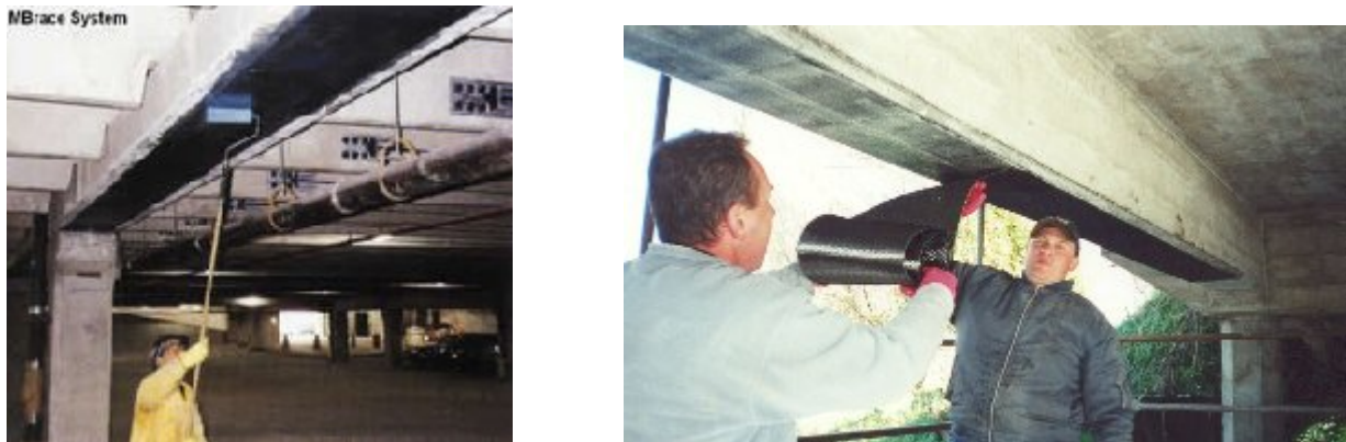
Figure I-19 Renforcement par collage de plats composites
