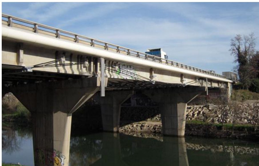
Figure II.4 : Application de la précontrainte additionnelle pour la réparation des ponts à poutres sous chaussée
