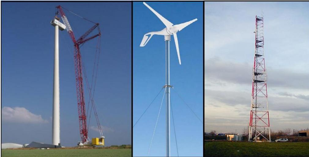
Fig.3 Type mat : a) Mat auto-porteur b) Mat haubané c) Mat en treillis métallique
