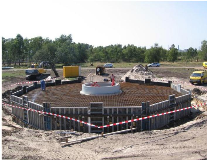
Fig.1 Fondation de l'éolienne.
