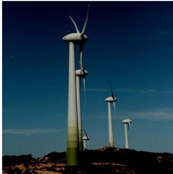
*Fig.11 Éoliennes synchrones Enercon E40 - Parc éolien de Punta Aja, Corse, France*
