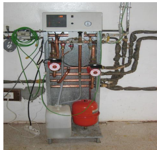
Figure II.12 : Présentation du module de transfert hydraulique [69].
