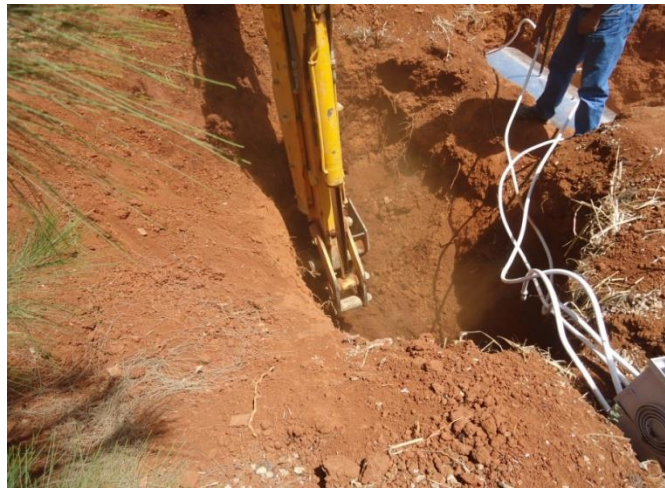
Figure II.8 : Réalisation de la fouille.
