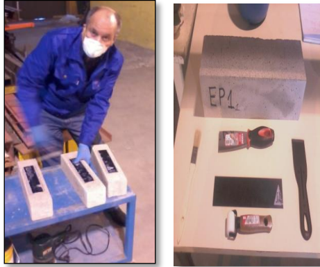
Figure 4-8 : Mise en œuvre de la réparation.
