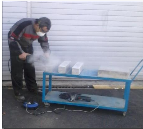
Figure 4-7 : Préparation du support.
