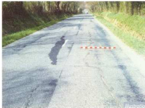
Figure 1.16 : Fissure d'adaptation
