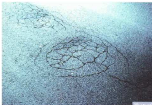
Figure 1.19 : Faïençage circulaire
