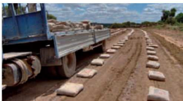
Photo III.2 : livraison en sac pour petit chantier (difficile d'accès) [Abdo, 2001].
