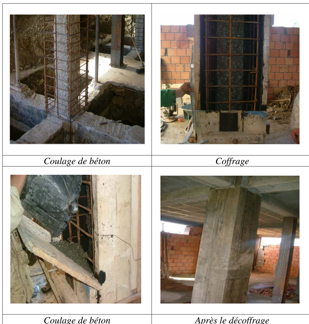
Figure III.2 : Réparation d'un poteau par augmentation de section. [23]
