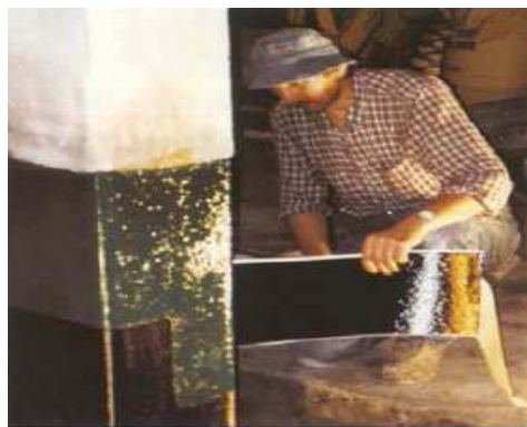
Figure.II.16 : polymère renforcé de fibre (PRF) appliqué in-situ.
