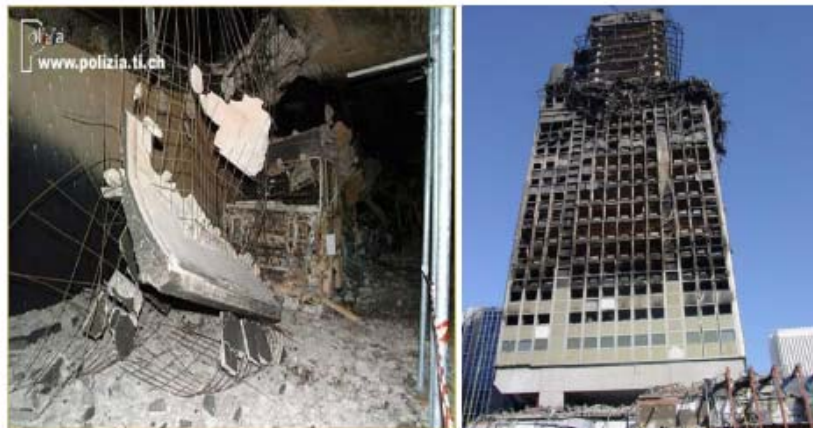
Figure I.15 : Photos des dégâts causées par l'incendie : A gauche, le tunnel du Saint Gotthard (Suisse) en 2001. A droite, la tour Windsor à Madrid en 2005.]
