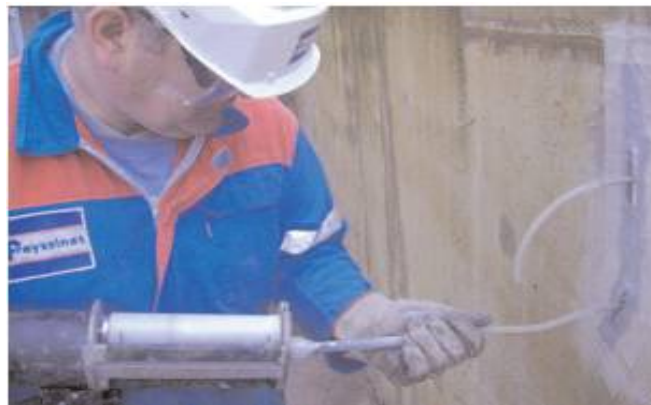
Figure II.4 : Pistolet manuel d'injection [26]
