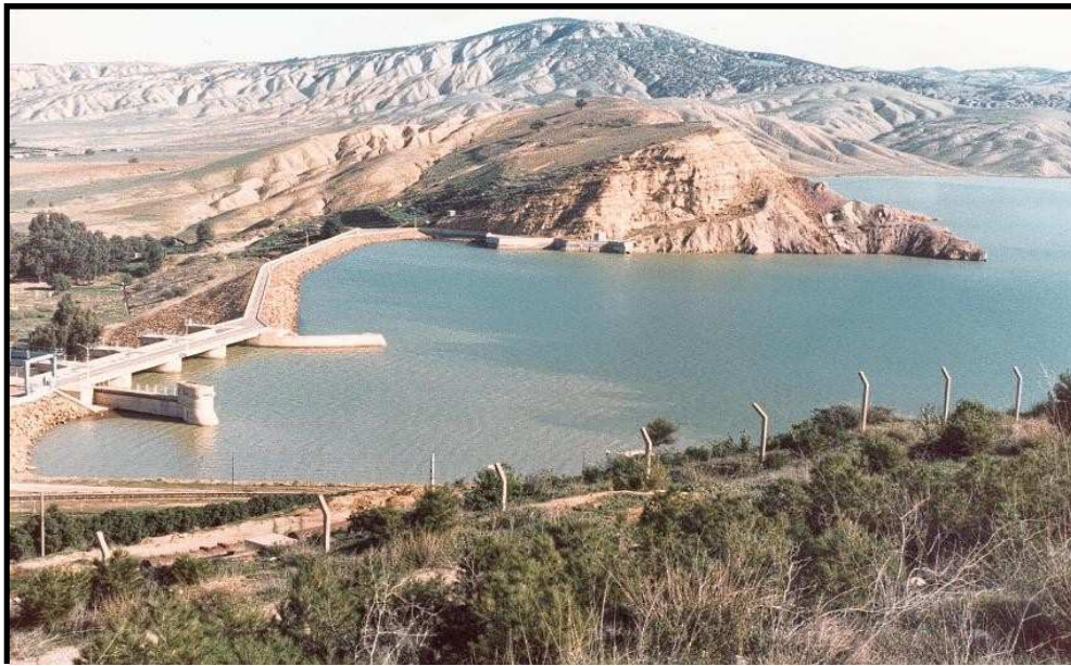
Photo 3 : Vue Générale - Barrage Fergoug
