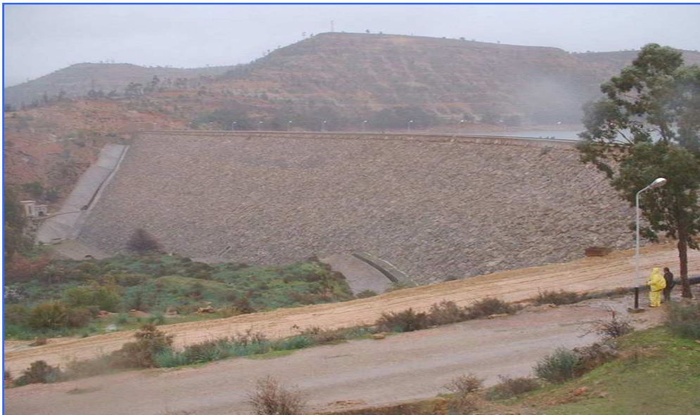
Photo 2: Vue Générale - Barrage Bouhanifia
