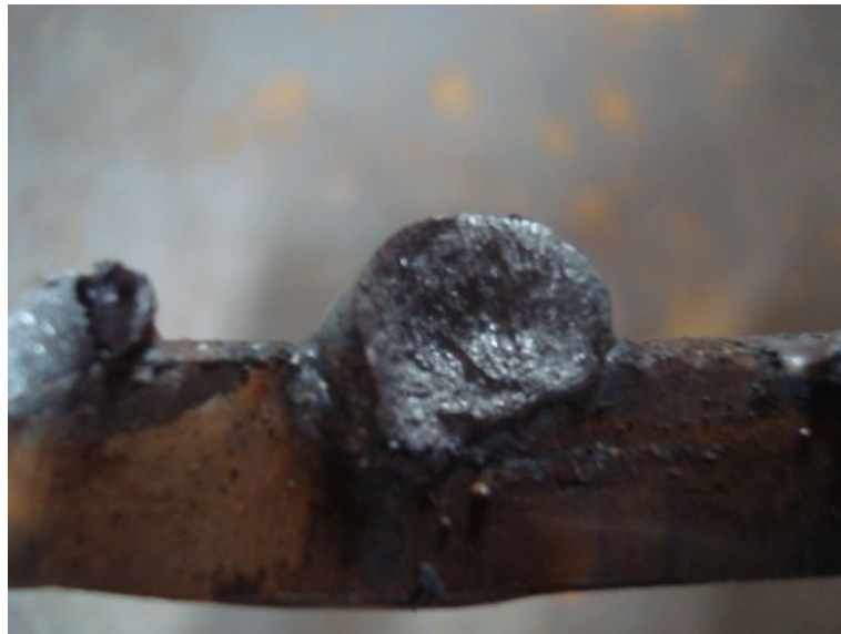
Figure 6 : facies d'une coupe due à la rupture d'un cordon de soudure
