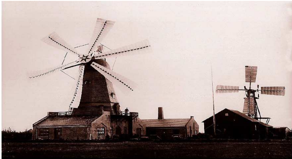
Fig.1.3 - Première aérogénératrice de Poul LaCour en 1891 à Askov, Danemark. [HAU06]
