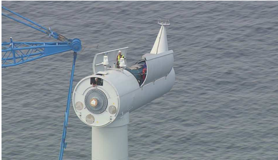
Fig.1.25 - Vue aérienne de la nacelle pendant l'assemblage d'une turbine éolienne.
