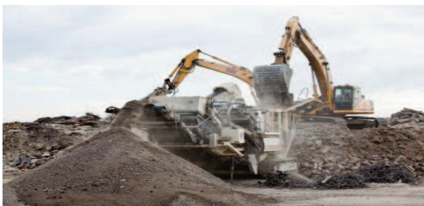
Figure.I.2 : Photo sur la récupération des déchets inertes
